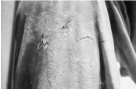
Fig 17 La imagen muestra Erosión, fisuras y lagunas con pérdida del material soporte.
