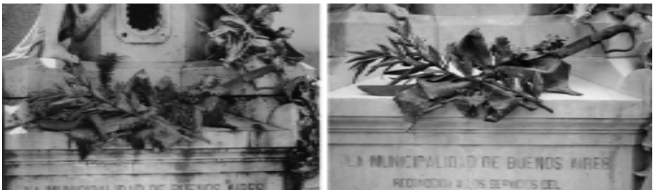
Fig 23 La imagen muestra: acumulación de óxidos en las placas de mármol- Pre y Post repatinado de ornato metálico monitoreado por Método Pourbex.
