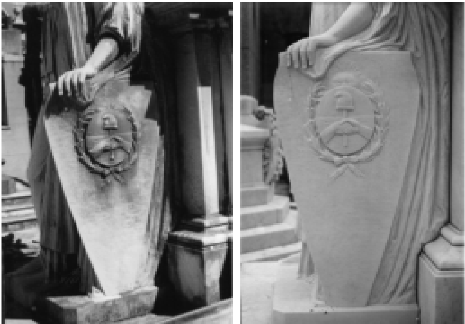
Fig. 29 La comparativa permite distinguir: eliminación de suciedad y neutralización de ataque biológico.
