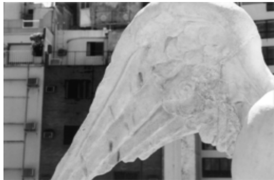
Fig. 38-39 La imagen previa a la restitución del ala, muestra la unión de las partes que la constituyen, donde a su vez ocurrió la caída y consecuente faltante del ala.
