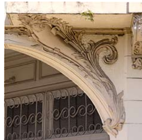
Ménsula de balcón en casa particular
