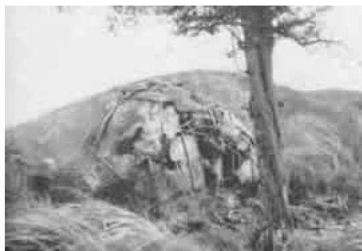
33. Cobertura de la choza: pieles de focas, sacos, vestidos, planchas metálicas.
